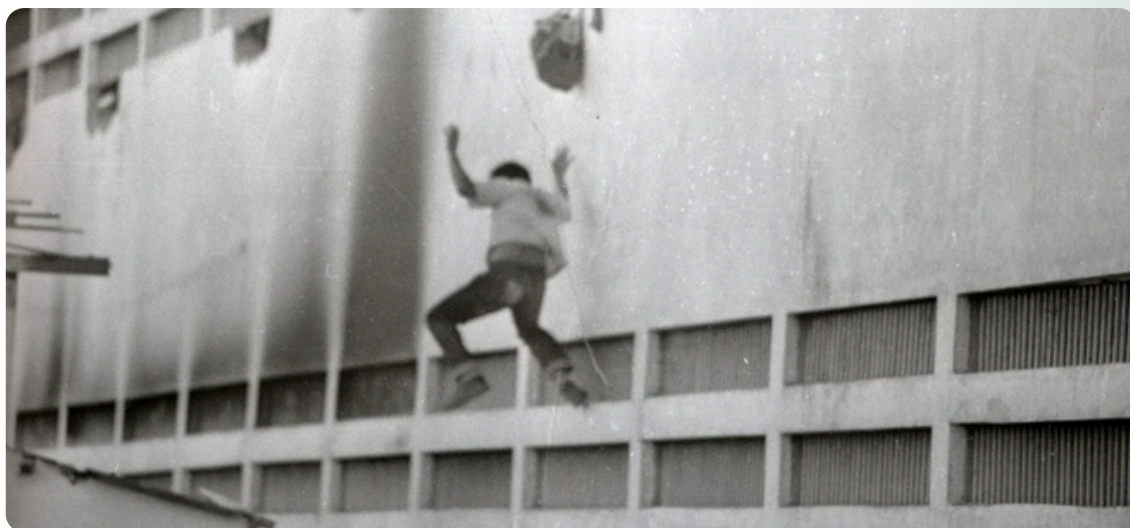
CASA DE DETENÇÃO DE VILA VELHA
